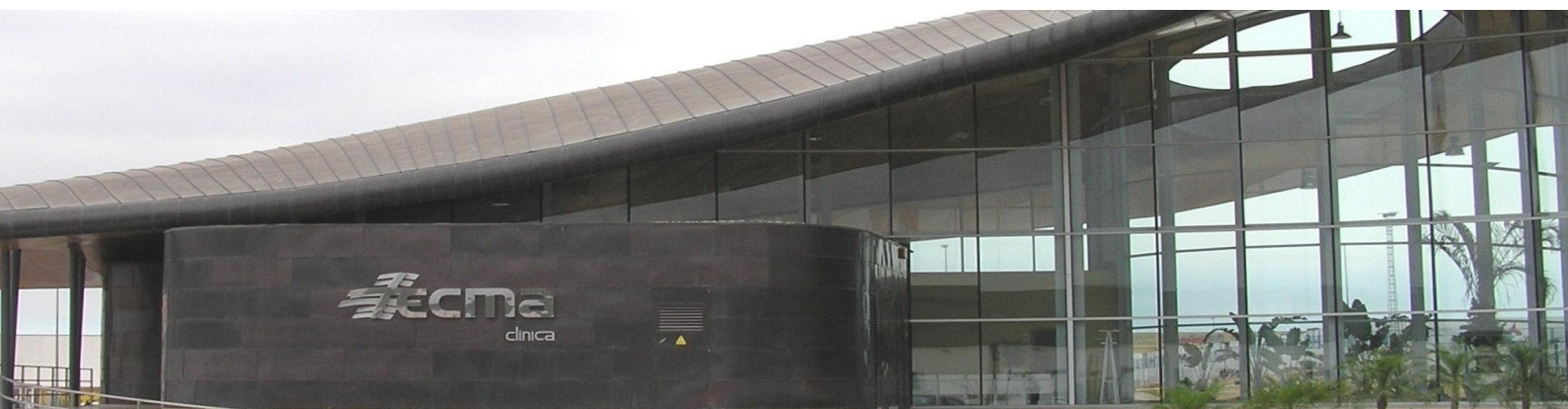
Edificio TECMA, Alcira, Alicante. Cubierta y fachadas en cobre preoxidado
