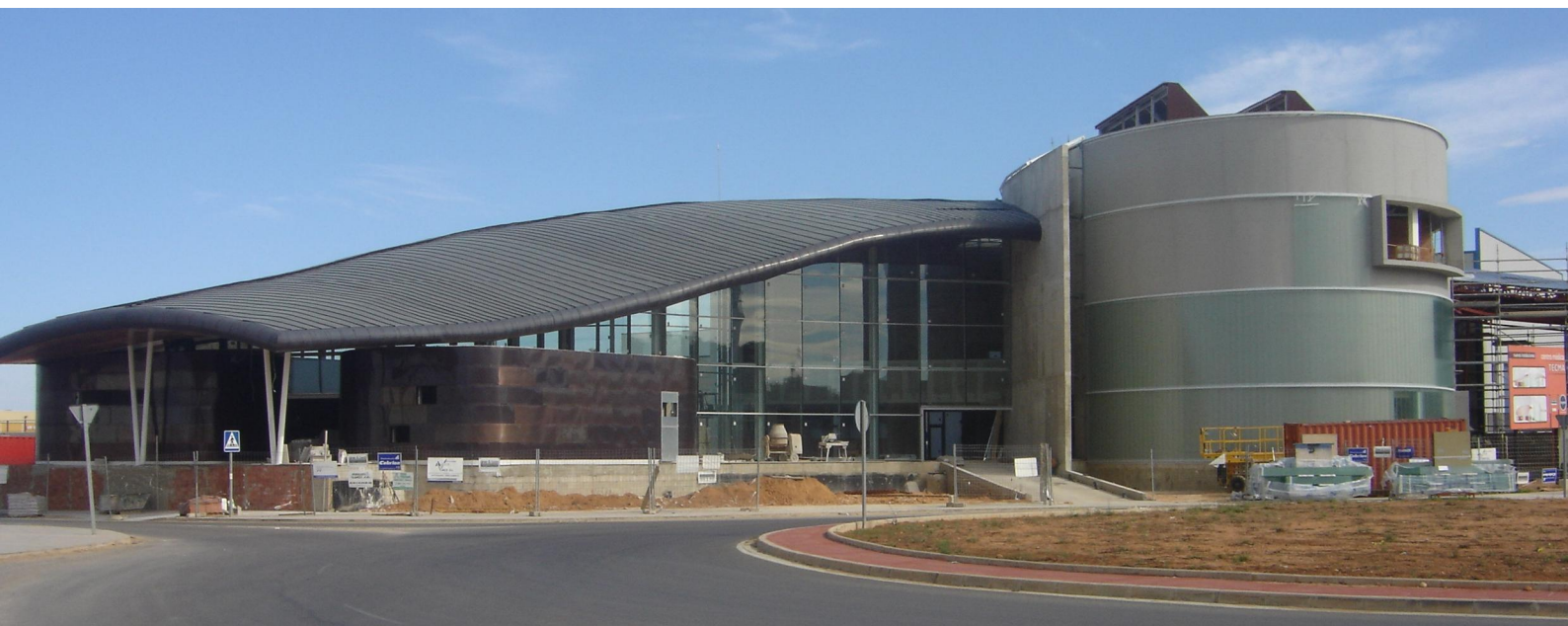
Centro Tecma, Alzira. Cubierta de junta alzada
