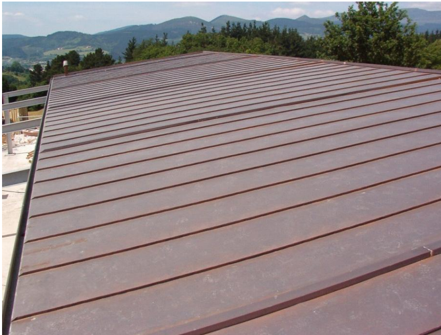
Peabellón de caza, Bitaño, Durango, Vizcaya. Cubierta de junta alzada
