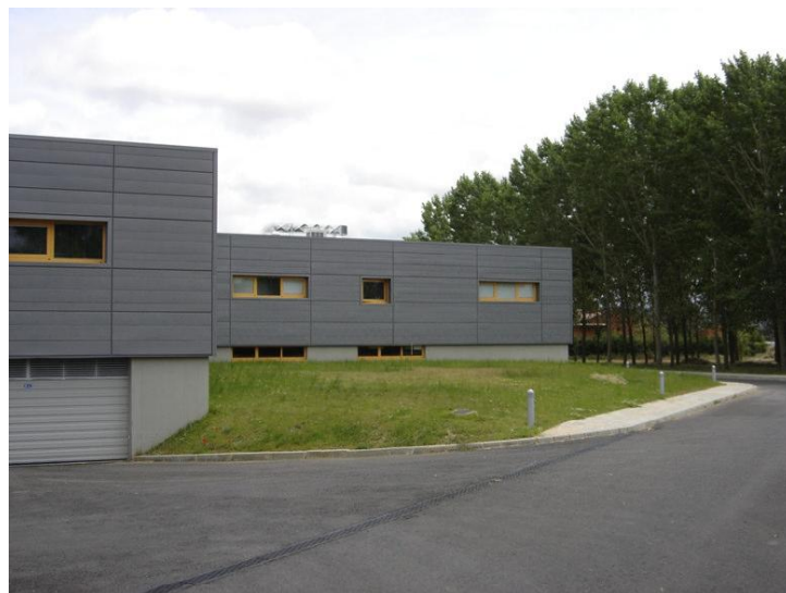
Laboratorio Regional de Sanidad Animal, Villaquilambre, León. Fachada de zinc prepatinado en paneles de fachada
