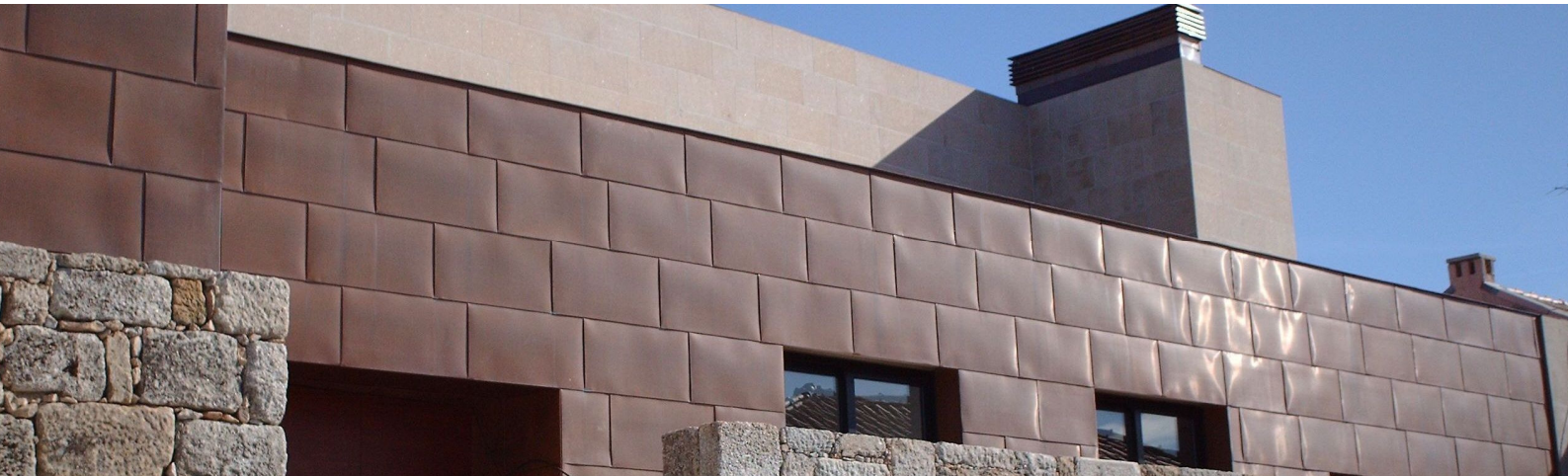
Fachada de cobre natural, vivienda unifamiliar, Guarda, Portugal
