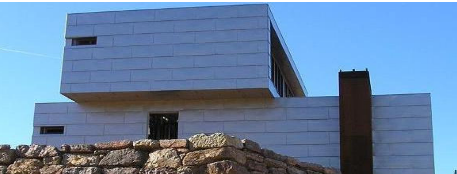
Vivienda unifamiliar en Carvajal de la legua, León. Fachada de junta plana
