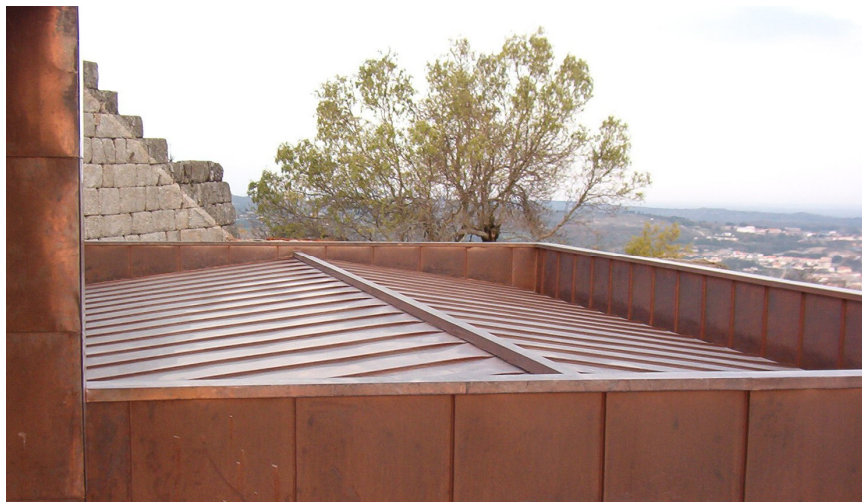
Vivienda unifamiliar en Guarda, Portugal. Cubierta de cobre natural.
