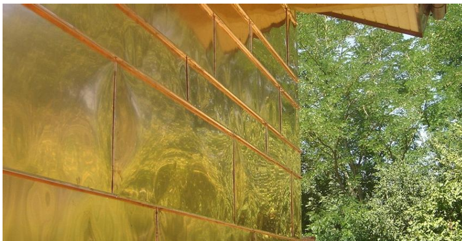
Bodega en Villa Verde de Trucios, Vizcaia. Fachada de junta alzada horizontal
